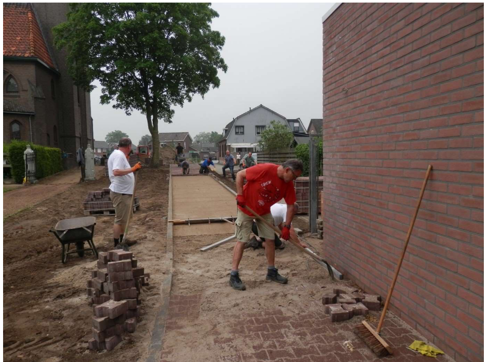
De contouren van de nieuwe verbinding worden zichtbaar.
